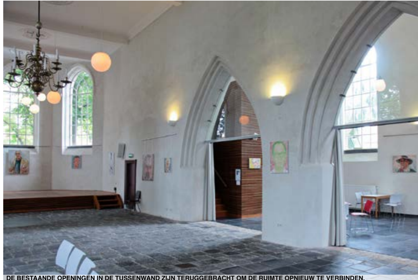
DE BESTAANDE OPENINGEN IN DE TUSSENWAND ZIJN TERUGGEBRACHT OM DE RUIMTE OPNIEUW TE VERBINDEN.
