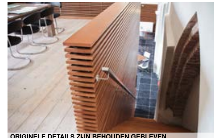
ORIGINELE DETAILS ZIJN BEHOUDEN GEBLEVEN
