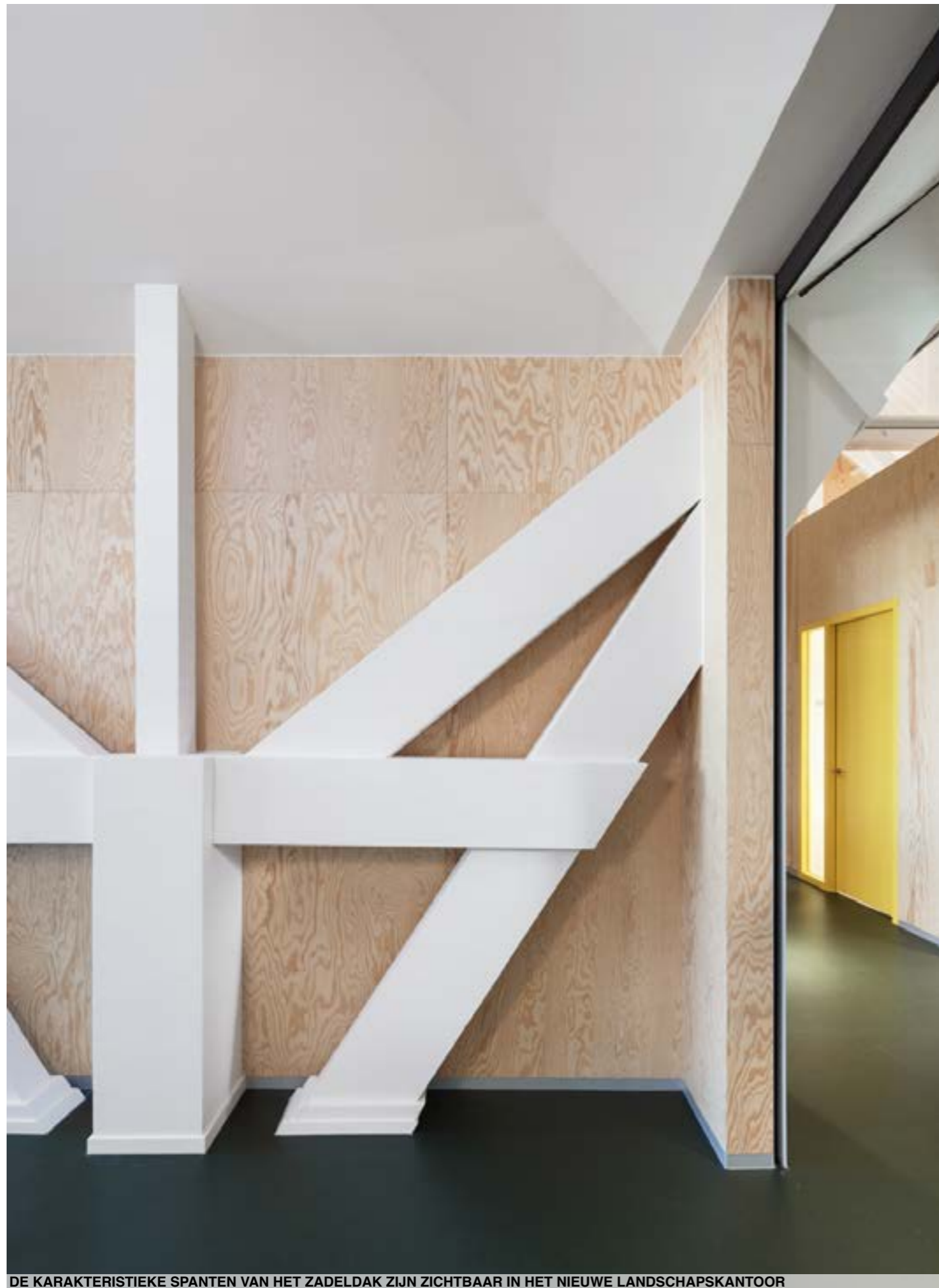
DE KARAKTERISTIEKE SPANTEN VAN HET ZADELDAK ZIJN ZICHTBAAR IN HET NIEUWE LANDSCHAPSKANTOOR
