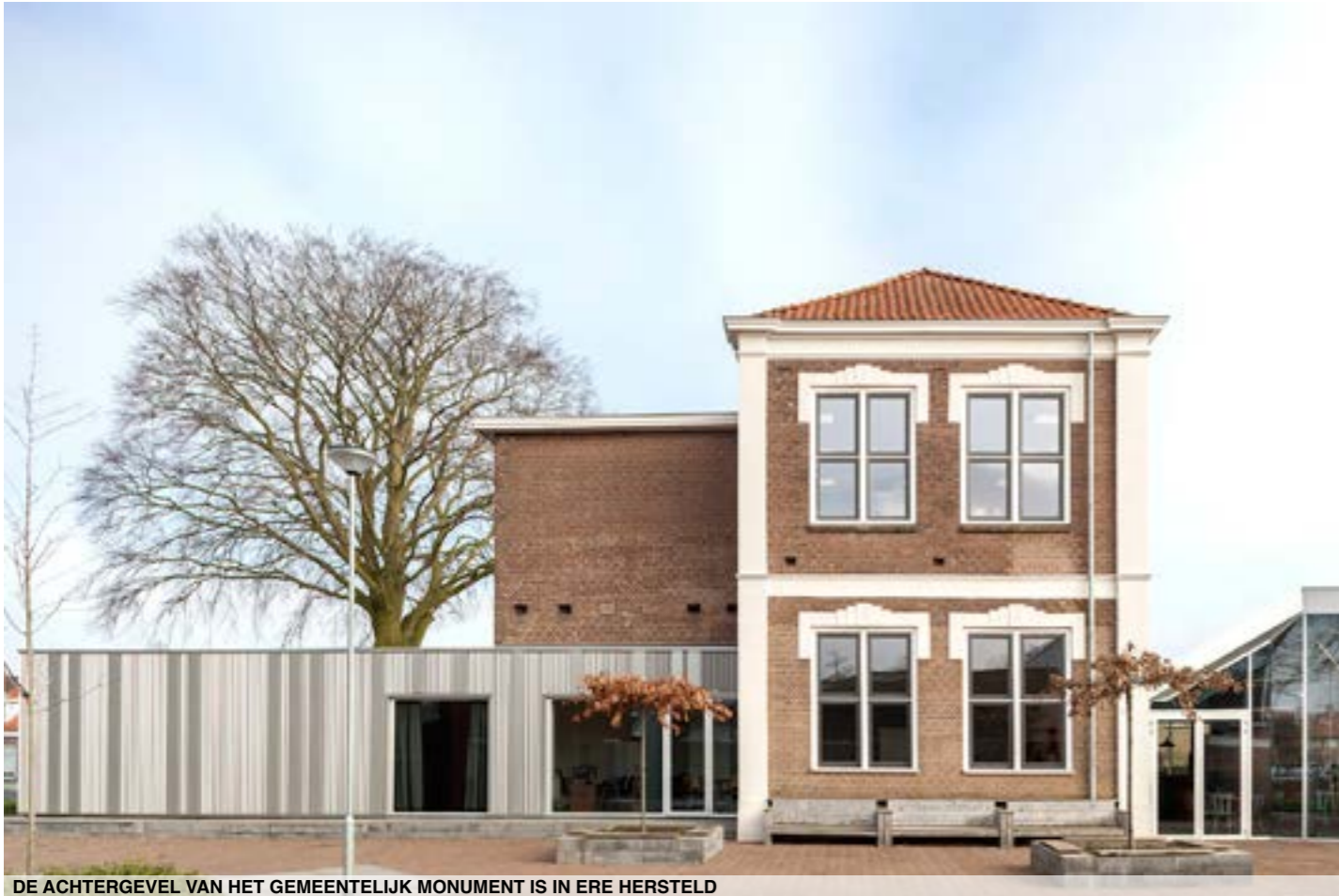
DE ACHTERGEVEL VAN HET GEMEENTELIJK MONUMENT IS IN ERE HERSTELD
