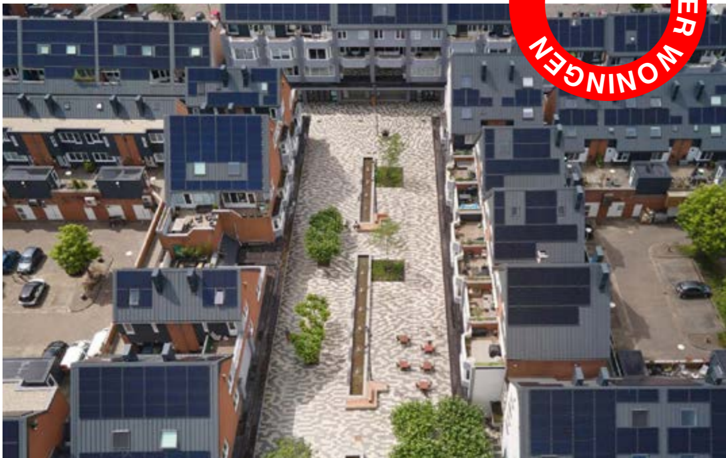
DE DAKEN VAN DE WONINGEN ZIJN VOORZIEN VAN ZONNEPANELEN. DAARBIJ ZIJN CO 2 GESTUURDE INSTALLATIES INGEPAST. OOK WORDEN DE DAKEN EN GEVELS VOORZIEN VAN EXTRA ISOLATIE EN DE KOZIJNEN EN HET GLAS WORDEN VERNIEUWD.
